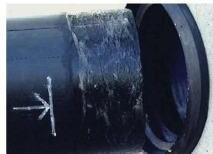
Bild 8: Herstellen der Rohranschlüsse
