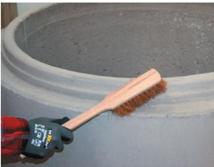
Bild 4: Reinigung der Verbindungsflächen
