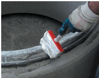
Bild 5: Auftragen des Gleitmittels
