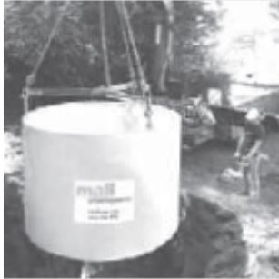
**Vorbemerkung:** Das Grundelement monolithischer Mall-Behälteranlagen besteht aus einem nach aktuellen Normen produzierten Stahlbetonfertigteil, das im „Über-Kopf-Verfahren“ hergestellt wurde. Die Produktionsweise macht es möglich, einen fugenlosen, vollständig stahlbewehrten Behälter ohne Arbeitsfuge im kritischen Anschnitt Wand-Sohle herzustellen.
