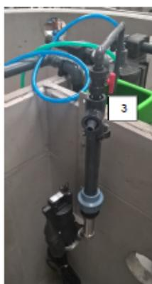
Nachrüstsatz Typ SanoSept zur Herstellung von Kleinkläranlagen mit einer dritten Reinigungsstufe zur Desinfektion des Abflaufs mittels UV-Strahlung für 4 - 50 EW; Ablaufklasse +H
