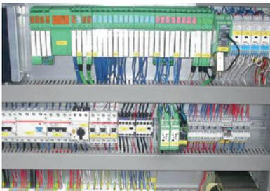
Neben den Standardsteuerungen sind auch jederzeit projektbezogene Sonderlösungen möglich. In diesem Bereich besitzt Mall große Projekterfahrung. Eine aktive Mitgestaltung von Kommunen und Betreibern zur Auslegung der Schaltanlage (z. B. Störmeldeweiterleitungen, Drehzahlregelung der Pumpen mittels Frequenzumrichter (FU), Fernwirken des Pumpwerkes o. ä.) ist jederzeit möglich.
