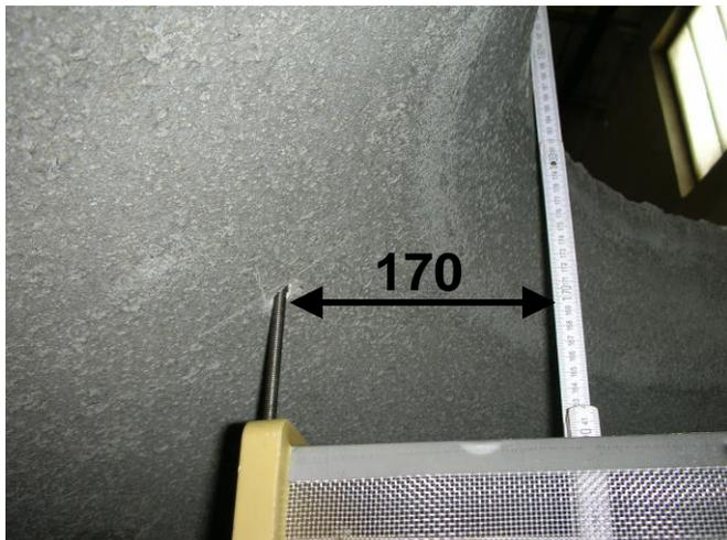
Der waagerechte Abstand zwischen Innenkante Einstiegsöffnung und Befestigungspunkt der Rohrschelle beträgt 170 mm
