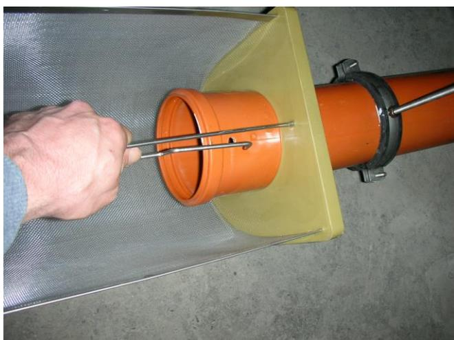
Der Filter wird auf das Rohrende geschoben. Hierbei ist darauf zu achten das der Fixierungsbügel angehoben wird und der Filter am Anschlag (Rohrschelle) ansteht.
