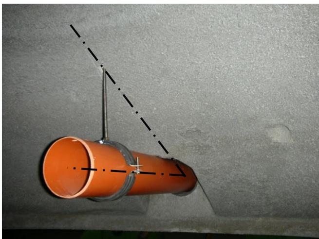
Die Befestigung der Rohrschelle im Konus liegt in der Flucht mit der Rohrachse
