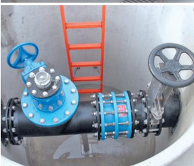
Wenn Druckleitungen mit Armaturen versehen werden, sind Mall-Armaturenschächte die richtige Wahl. Montagefertig angeliefert, ist ein schneller Einbau und eine hohe Qualität durch die Werksmontage möglich. In enger Zusammenarbeit mit dem Planer verwendet Mall für Rohrleitungsmaterialien und Armaturenausrüstungen ausschließlich hochwertige, korrosionsfreie Werkstoffe.
