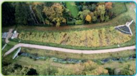
Multifunktionale Anlagen zur Regenwasserbehandlung und -Bewirtschaftung
